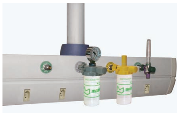
Tomadas elétricas universal 2P+T, conforme norma ABNT NBR 14136:2002.
